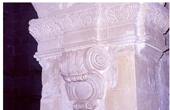
Mènula d'una de les pilastres del claustre
